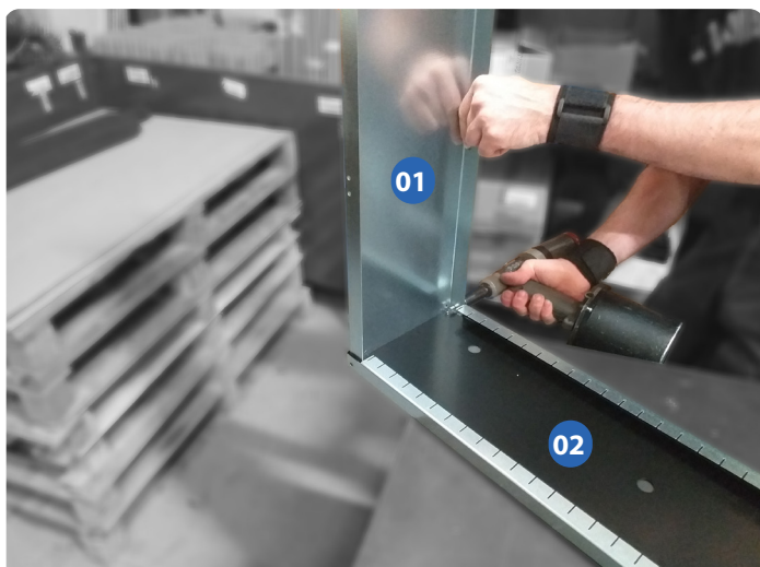
3.- Fijar el lateral izquierdo al suelo con 4 elementos de fijación (remaches o tornillos roscachapa). La chapa lateral va por dentro de la chapa de suelo.
