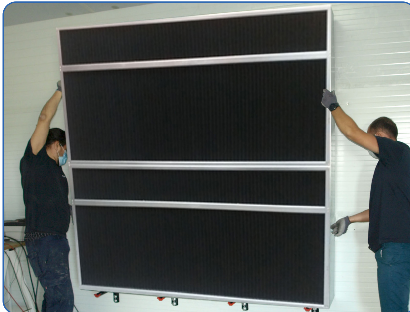
Img.16. Subir la trampa de luz sobre los soportes.
