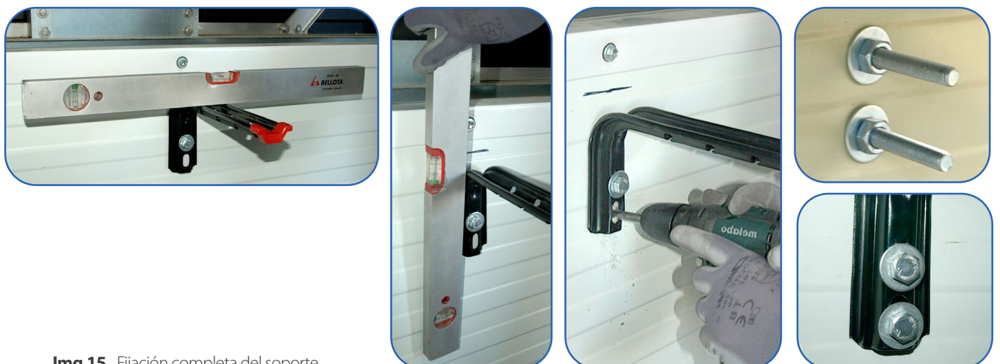
Img.15. Fijación completa del soporte.
