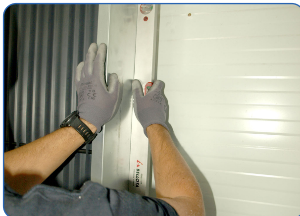
Img. 17. Comprobación con nivel.
