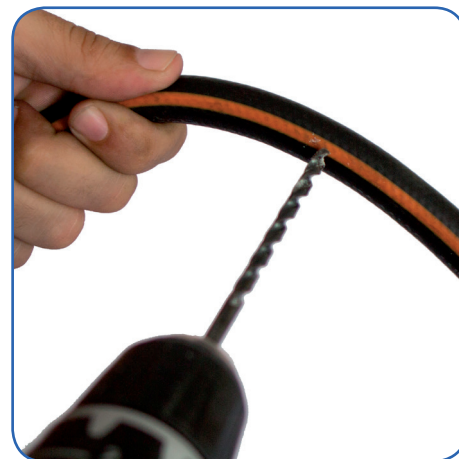
Figura.27. Taladramos la manguera de agua a la altura de la nave donde irá colocado el bebedero.
