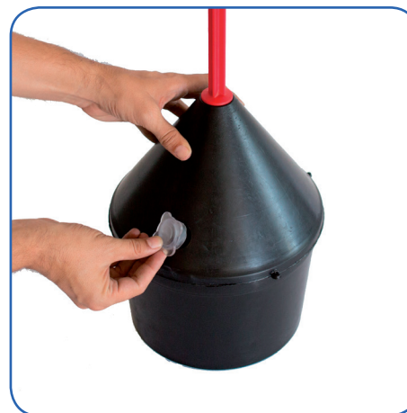
Figura.05. Colocar el tapón para evitar fugas de agua.
