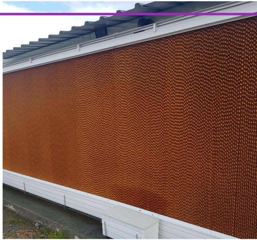
El sistema se basa en el enfriamiento evaporativo por caída de agua sobre un panel de celulosa, situado en la ventana, por el que pasa el aire. El proceso provoca la evaporación del agua, aumentando la humedad relativa y disminuyendo de esta manera la temperatura.
